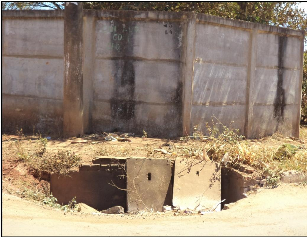
Figura 141 - Falta de manutenção no sistema de drenagem no Residencial Triunfo.
