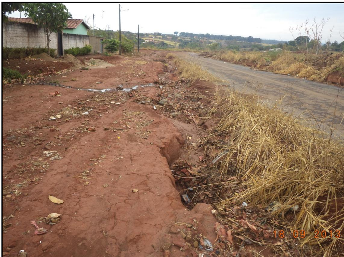
Figura 145 - Localização de um ponto de erosão devido à falta de drenagem.
