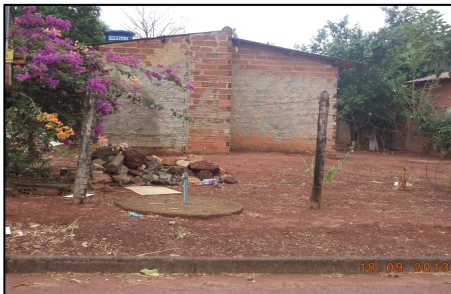
**Figura 106 - Fossa negra instalada próxima à calçada de pedestres.**
