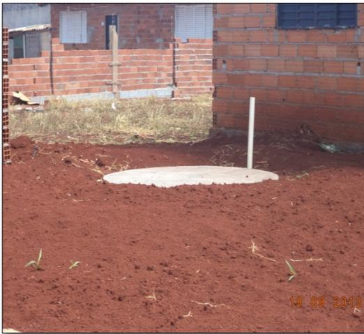
**Figura 100 - “Fossa negra” instalada na calçada localizada no setor Sobradinho. Fonte: Hollus (2013).**
