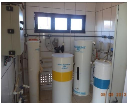
Figura 61 - Sistema de dosagem de Cloro.
