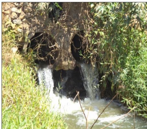
Figura 98 - Estrutura de lançamento do efluente tratado. Fonte: Hollus (2013).
