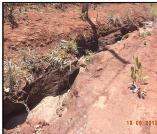
Figura 34 - Erosão Laminar causado pela falta do Sistema de Drenagem de Águas Pluviais.
