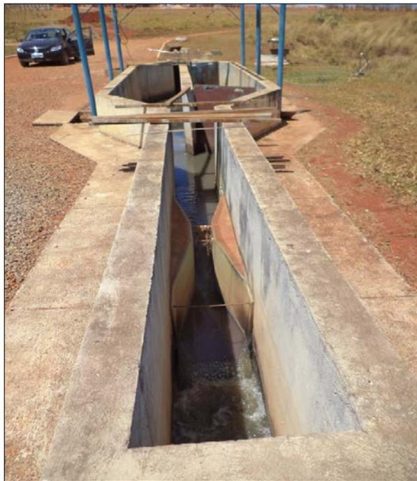
Figura 90 - Caixa de Areia seguida de Calha Parshall.
