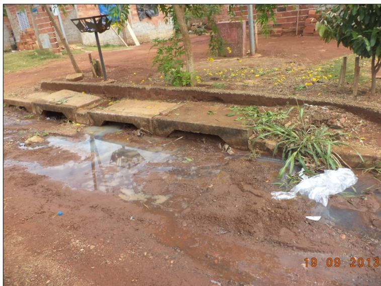
Figura 148 - Microdrenagem saturada no Res. Triunfo I.
