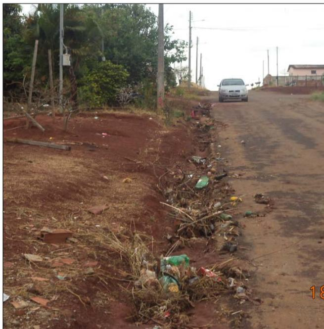
Figura 131 - Falta de estrutura de drenagem no Setor Serra Dourada.
