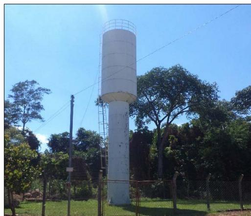
Figura 75 - Reservatório tipo taça – Condomínio Recanto das Águas. Fonte: Hollus (2015).
