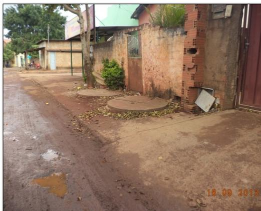
Figura 102 - “Fossa séptica e sumidouro instalado na calçada localizada no setor Sobradinho. Fonte: Hollus (2013).
