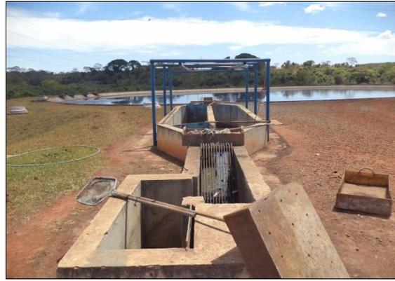
**Figura 13 - Tratamento Primário: Remoção de Material Grosso.**
