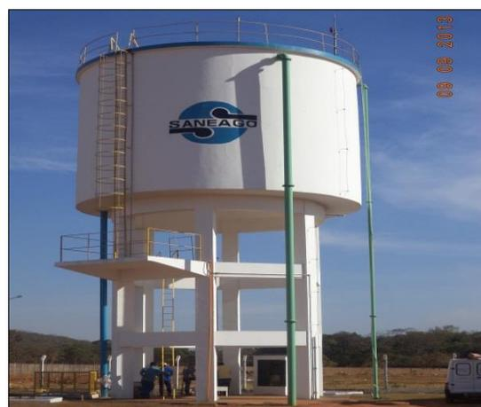
Figura 12 – Sistema Núcleo Urbano Área de Tratamento e Reservação/Reservatório Elevado de Distribuição CAP 200 m<sup>3</sup>.
